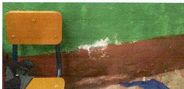
pintura en interior y exterior en ambas aulas.
