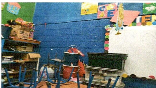
Cernido de paredes en ambas aulas
